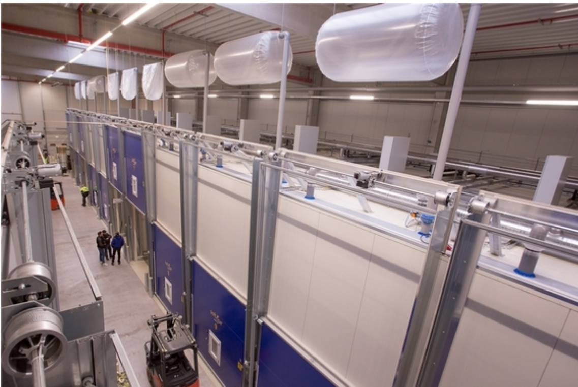
Die Plastikbeutel sind die Lungen der Reifekammern. Sie regeln die Luftzufuhr im Innern. Foto: Landgard
